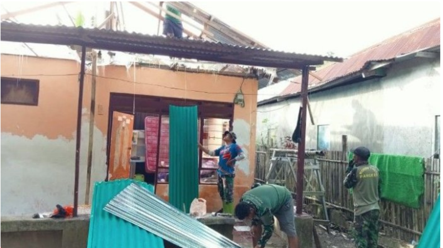
Kodim 1421/ Pangkep Korem 141 / TP Gelar Bedah Rumah Terhadap Rumah Warga Tidak Layak Huni di Padoang Doangan
